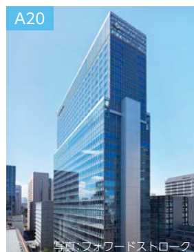
A20 アーバンネット内幸町ビル (港区新橋一丁目)
