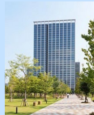
品川シーゾントラス 延床面積：206,025.07㎡
