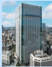
赤坂トラストタワー 延床面積：209,436.75㎡
