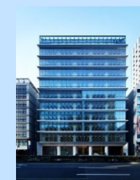
写真：フォワードストローク アーバンネット 日本橋二丁目ビル 延床面積：14,674.49㎡
