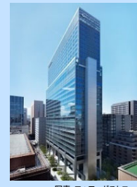
写真：フォワードストローク アーバンネット 内幸町ビル 延床面積：36,145.48㎡
