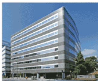
アーバンネット三田ビル 東京都港区
